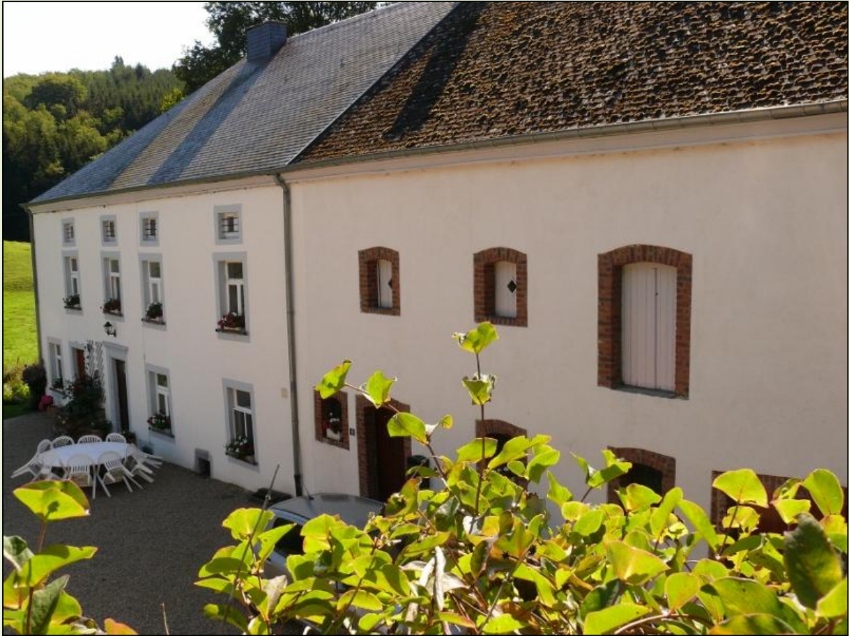
Soller Mühle, Vorderansicht - Die beiden letzten Farbaufnahmen stammen vom 15. August 2011
